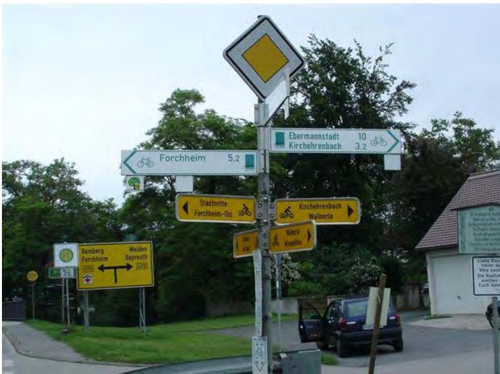
Der Schilderpfosten ist überladen mit Zusatzschildern, die besser als Einhängern in den Pfeilwegweisern untergebracht wären. Die existierende Wegweisung ist irreführend (zweimal zum Walberla in unterschiedliche Richtungen, nach Süden und Osten)
