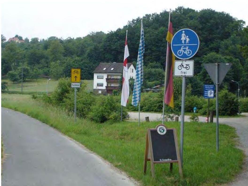
Der Pfosten müsste ersetzt werden, da er für die Pfeilwegweiser zu niedrig ist. Montagehöhe der Pfeilwegweiser mit Einhängern 2,5 m.
